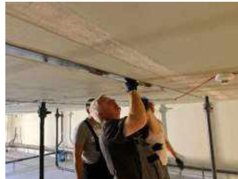
Deckenverstärkung mit CFK Lamellen Therapiebecken - PVA Felbring - 2020
