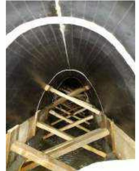
Sonderstahlschalung & Verstärkung Tragwerk mit SCC Beton - Instandsetzung Durchlass Bahnhof Bad Gastein - 2021
