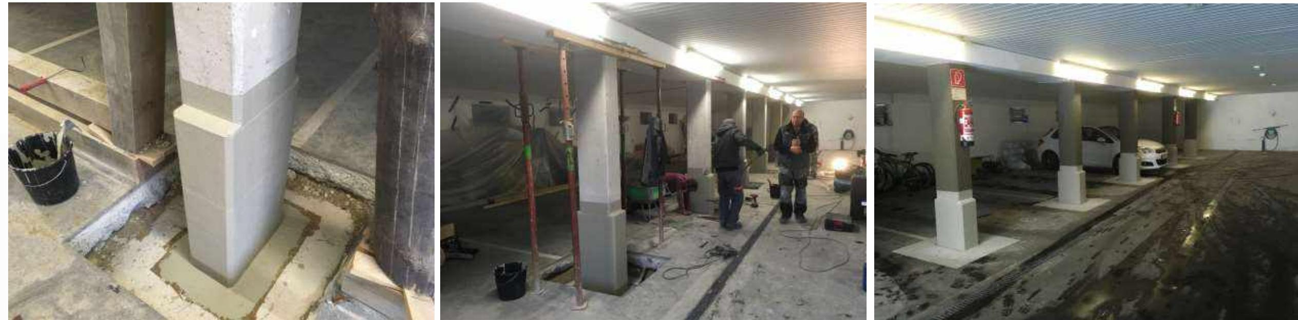
Abdichtung der Stützfüße mittels Flüssigkunststoff - Tiefgarage Gutau - 2017
