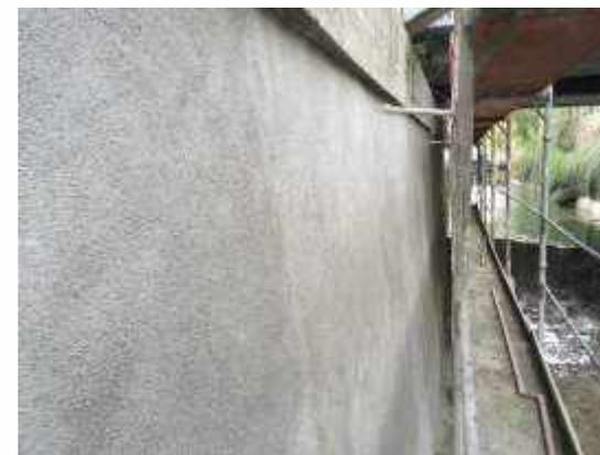
Instandsetzung im Trockenspritzverfahren - Hochwasserschutzmauer Linz Ebelsberg - 2016
