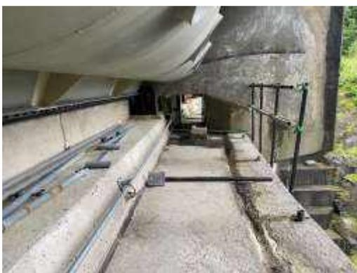
Instandsetzung & Abdichtung mit Flüssigkunststoff – Podeste Überlaufklappen Sperre Paal Stmk. - 2023
