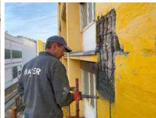
Instandsetzung Stahlbetonstützen & Träger – Haus Rechberger Linz - 2023
