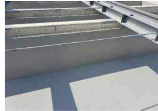
Abdichtung Trafowannen mit Flüssigkunststoff – Umspannwerk Neusiedl a.d. Zaya - 2023
