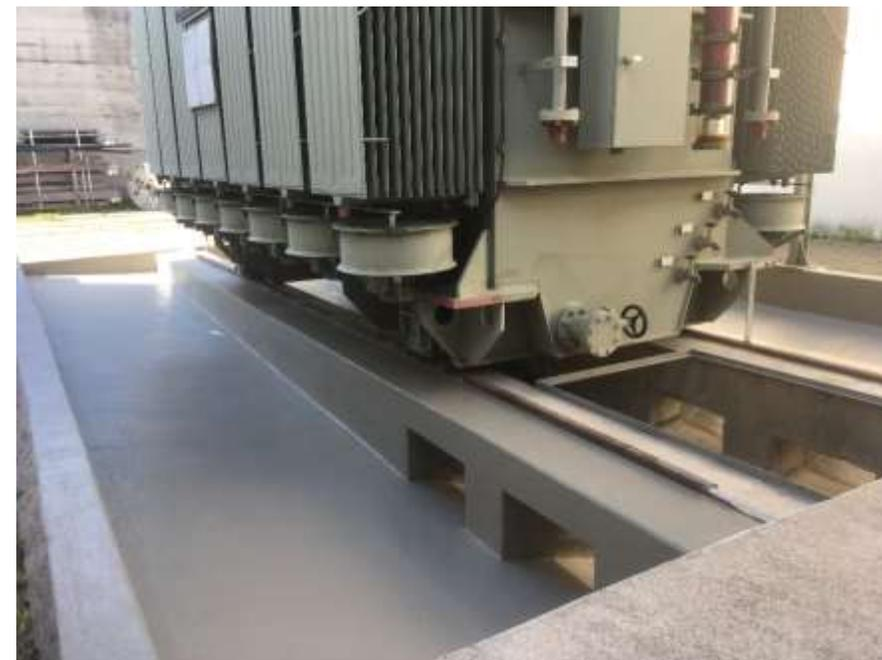
Abdichtung der Trafograben mit Flüssigkunststoff - Innkraftwerk Eggfing Obernberg - 2018
