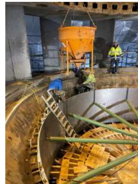
Erneuerung Laufradmantel Maschine 2 - Kraftwerk Ering - 2022
