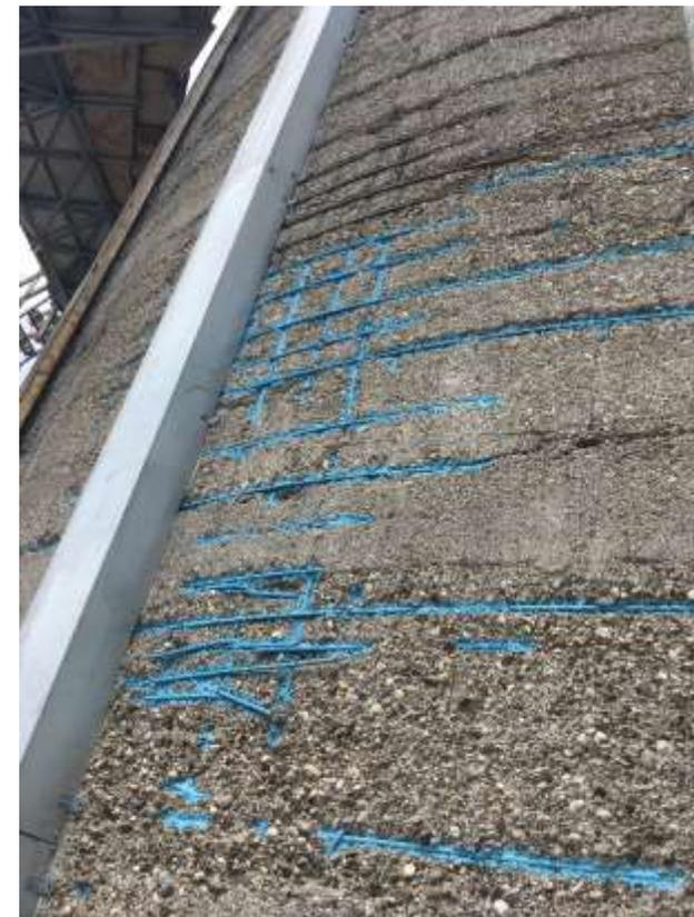
Instandsetzung der Tragkonstruktion im Nassspritzverfahren - Mischturm Wessenthaler Attnang Puchheim - 2019
