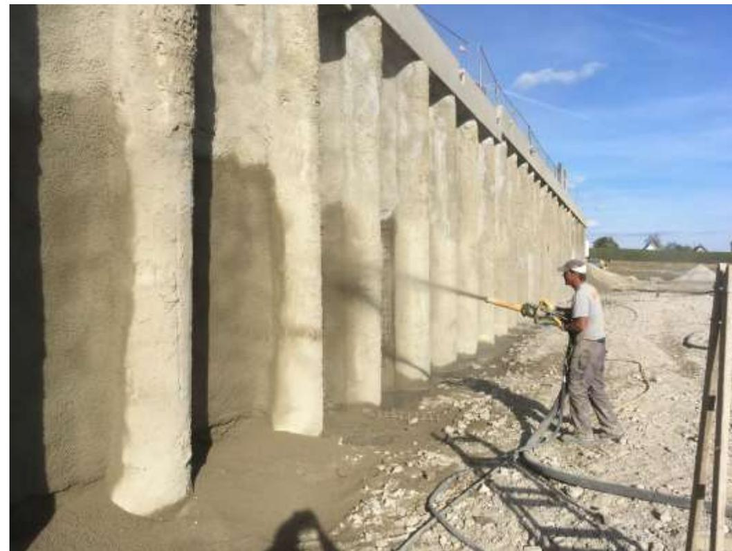
Aufgelöste Bohrfahlwand Trockenspritzbeton - Eder Systembau - 2017 und 2019
