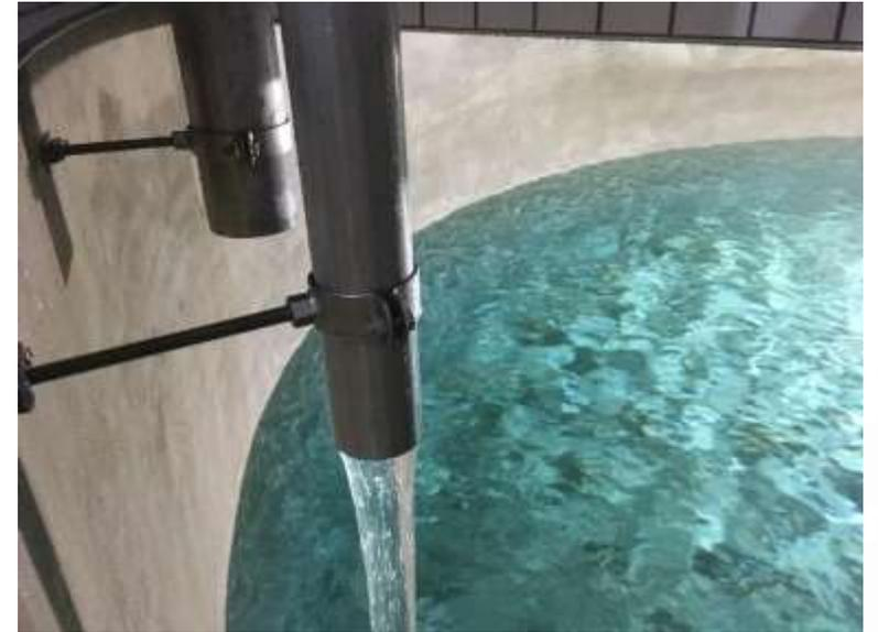
Mineralische Beschichtung in den Wasserkammern im Nassspritzverfahren - Hochbehälter Petersham Lochen am See - 2017
