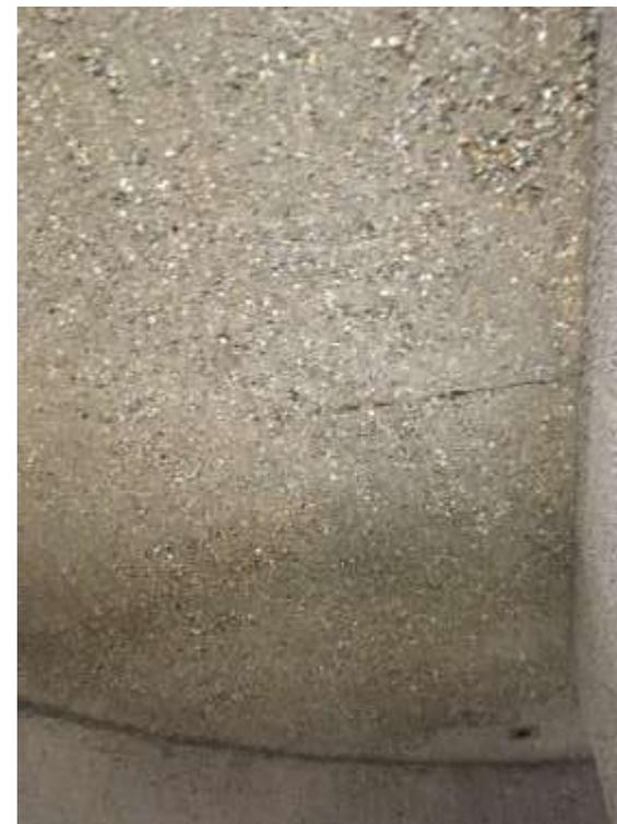
Mineralische Beschichtung der Wasserkammer im Nassspritzverfahren - Hochbehälter Mauterndorf - 2020
