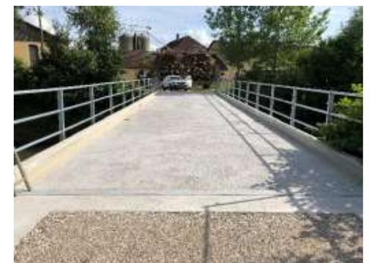
Instandsetzung & Erneuerung Fahrbahnplatte – Umbau zu einem Verbundtragwerk – Huemerbrücke Kremsmünster - 2021
