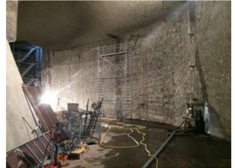
Rissinjektionen im Turbinenraum - Innkraftwerk Ering Frauenstein - 2017
