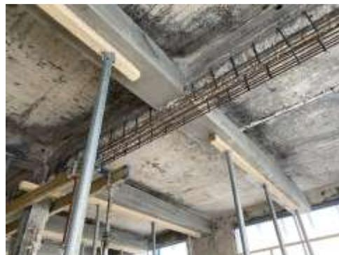
Instandsetzung Brandschaden – Tragwerksverstärkung mit STB Verbundträger & STB Stützenummantelung
