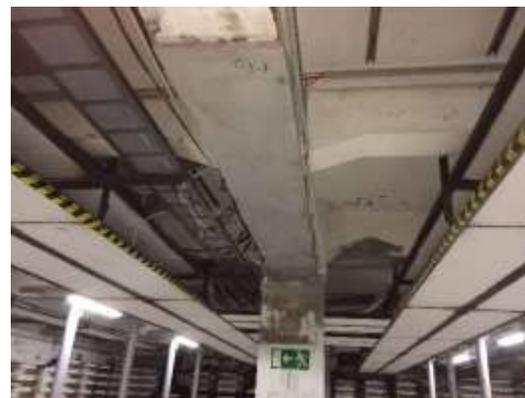
staubfreie Betoninstandsetzung Decke Schaltzentrale, inkl. Trockeneisstrahlen & Stahlbau - Umspannwerk St. Peter/Hart - 2017
