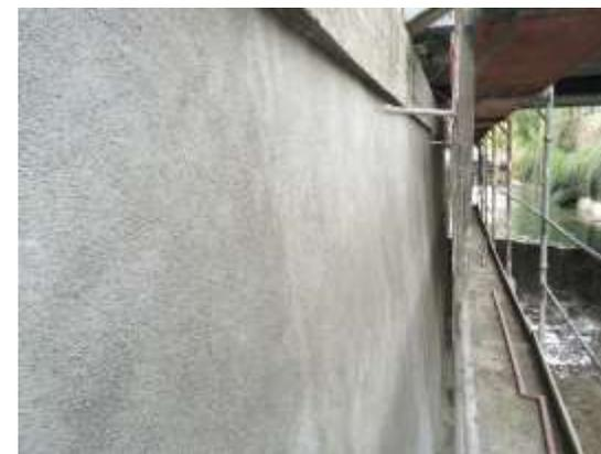
Instandsetzung im Trockenspritzverfahren - Hochwasserschutzmauer Linz Ebelsberg - 2016
