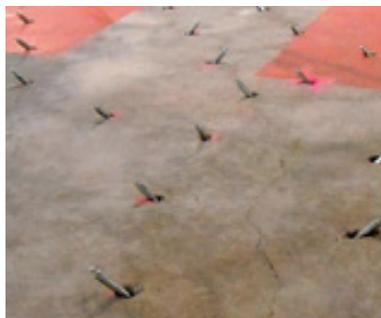
Bohrpacker für Rissinjektion
