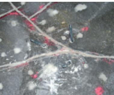
Rissinjektion an Bodenplatte
