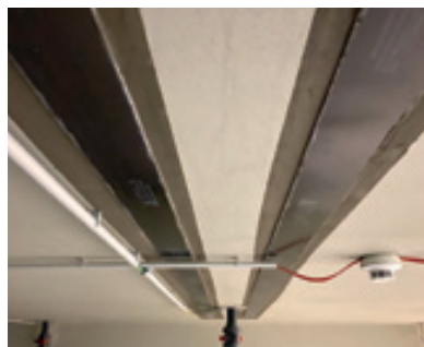
Deckenverstärkung mit CFK-Lamellen
