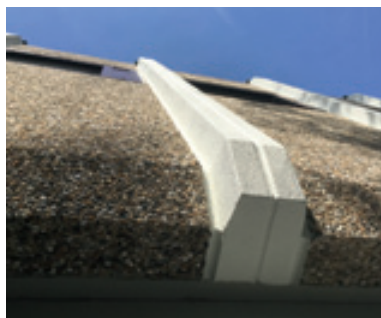
Instandsetzung und Beschichtung Tragkonstruktion
