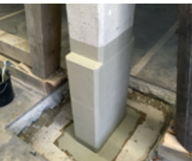
Instandsetzung und Verstärkung von Stahlbetonsäulen
